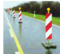
Luces amarillas fijas o intermitentes
